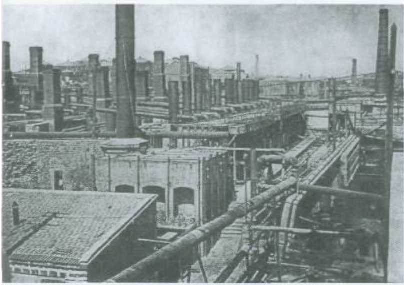
Şəkil 28. Ağşöhərdə “Qırmızı ulduz” elektrik stansiyası (1925)
