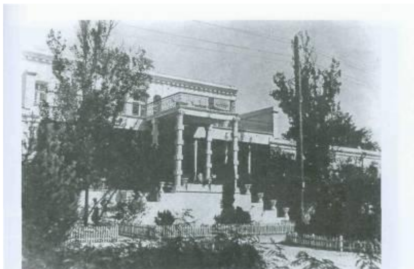
Şəkil 32. Mərdəkan qəsəbəsində neftçilərin istirahət evi
